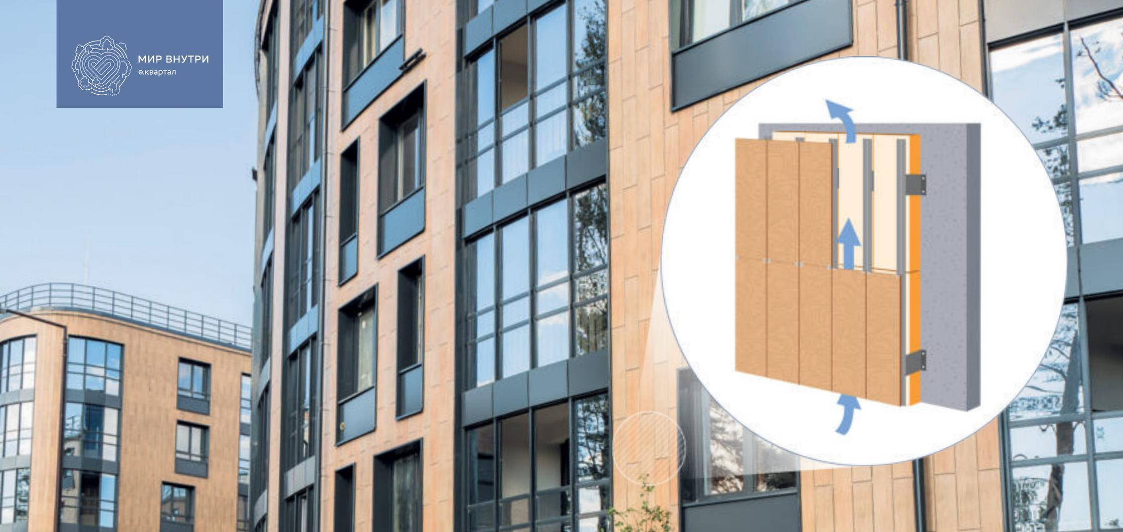
Наши дома строятся по монолитной технологии, а вентилируемые фасады позволяют монолиту «дышать». Это обеспечивает зданиям отличную теплоизоляцию и долговечность. Благодаря пространству между стеной и облицовкой повышается устойчивость строения к атмосферным явлениям,
